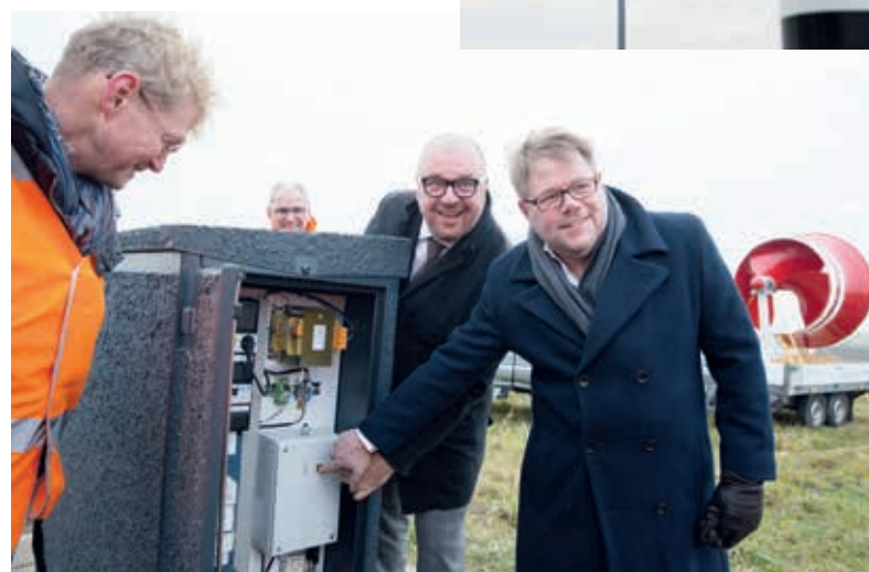
Wethouders John Nederstigt (links) en Derk Reneman stellen de installatie in werking waarmee de windmolen energie levert voor de verkeersregelinstallatie.
