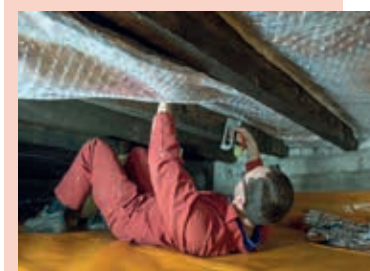
Het aanbrengen van vloerisolatie. Foto: Regionaal Energieloket.
