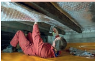
Het aanbrengen van vloerisolatie. Foto: Winst uit je woning
